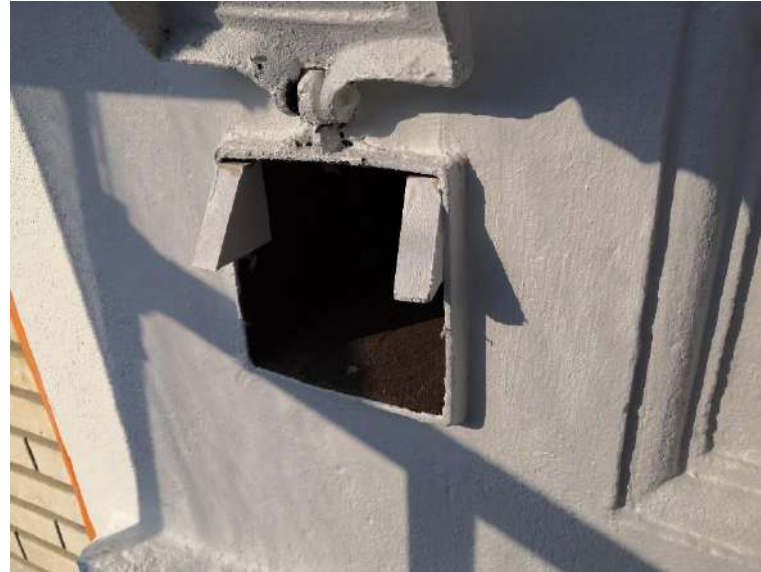
Mise en peinture
