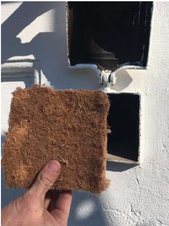
Carré prédécoupé de fibres de bois qui permet d'isoler le fond du trou de boulon
