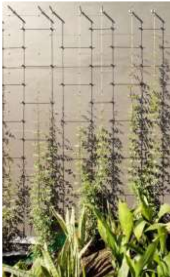
Draagstructuur met latwerk - Bron: Jakob Rope Systems
