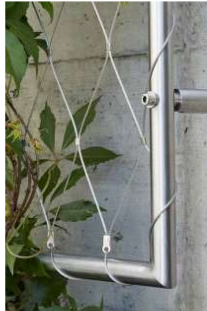
Draagstructuur met net Bron: Jakob Rope Systems
